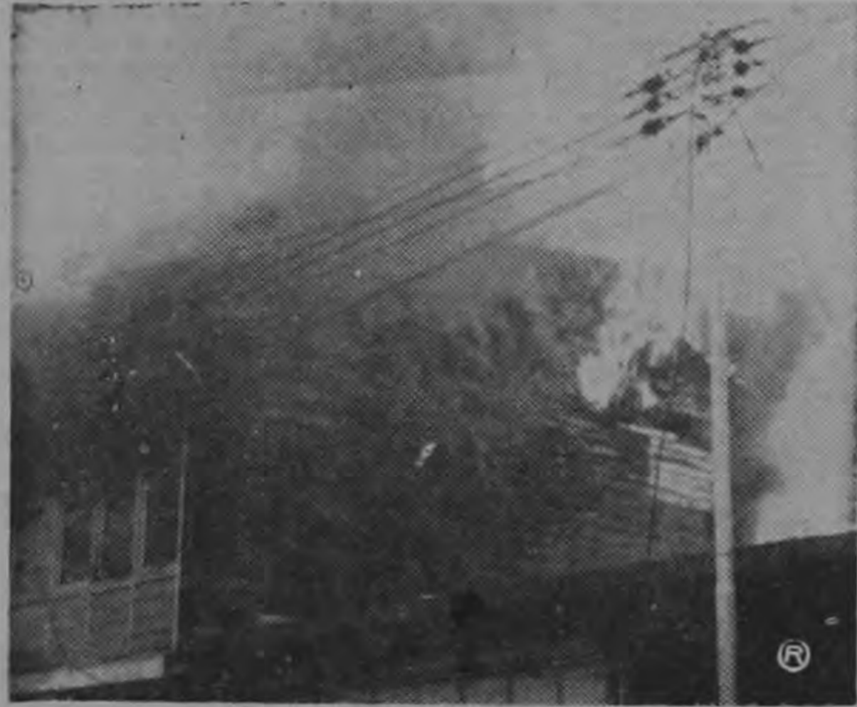
DRAMATICA FOTOGRAFIA tomada por un guadalupano alerta, cuyo nombre lamentablemente no pudimos obtener. En esta foto puede apreciarse que aparentemente el incendio empezó en la parte superior del inmueble. En los instantes en que fue tirada esta oportuna placa, las bombas y equipos se dirigían al lugar a toda velocidad.
